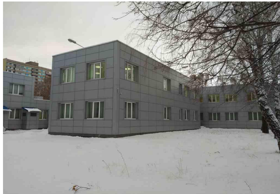
Общий вид административного здания
