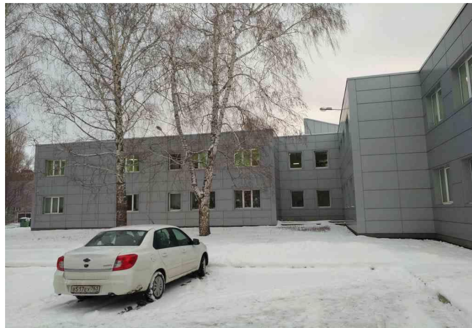
Общий вид административного здания
