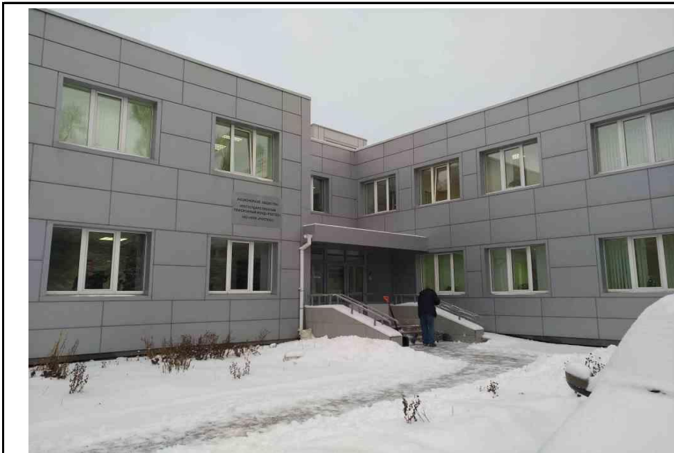
Общий вид административного здания
