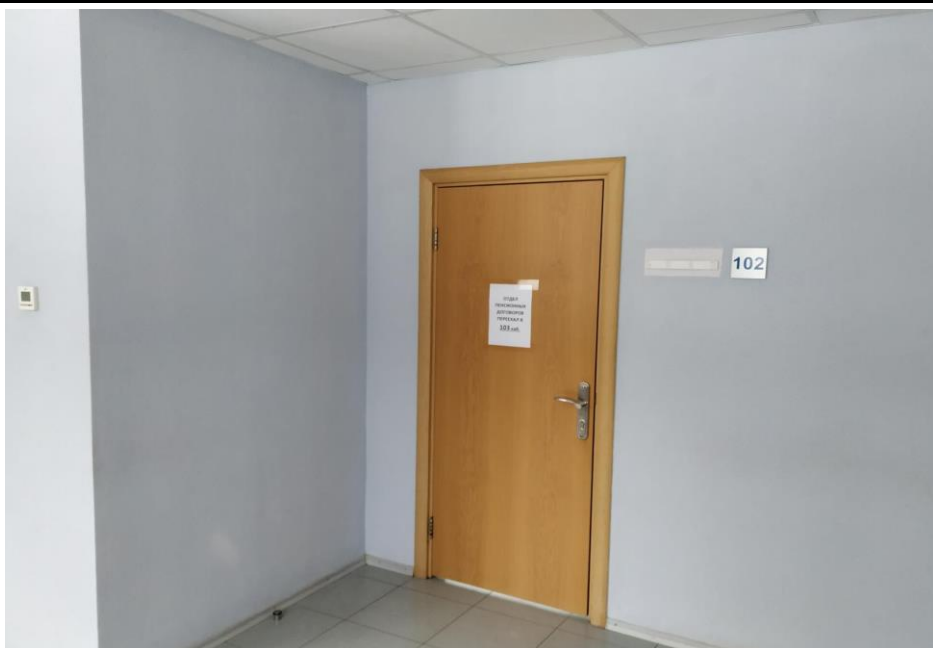
Вид помещений административного здания
