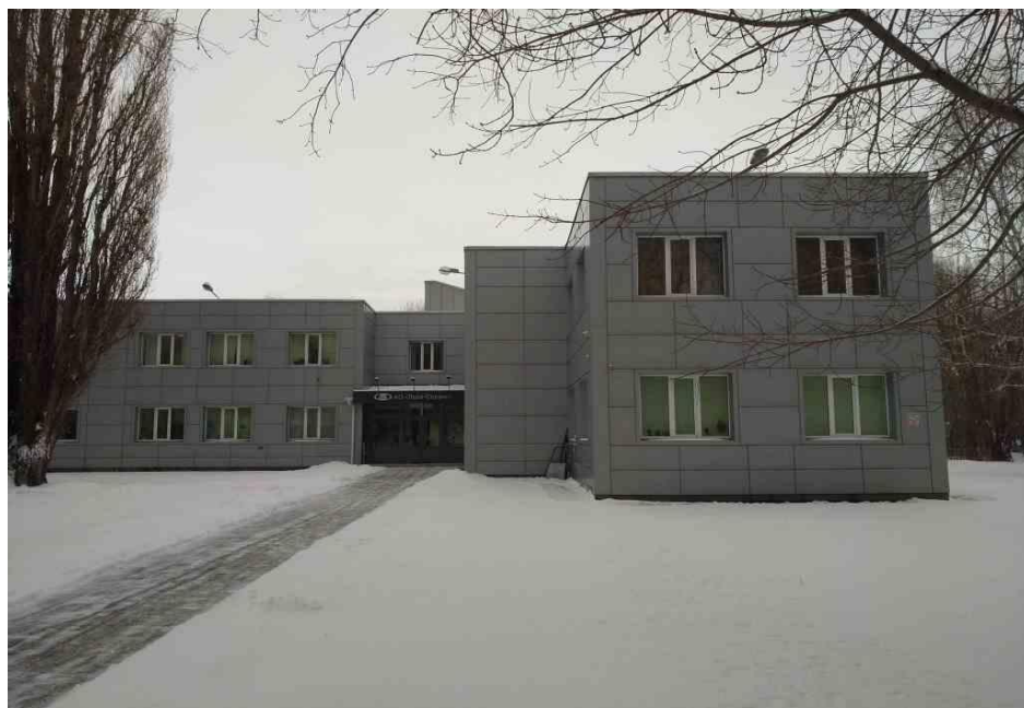
Общий вид административного здания
