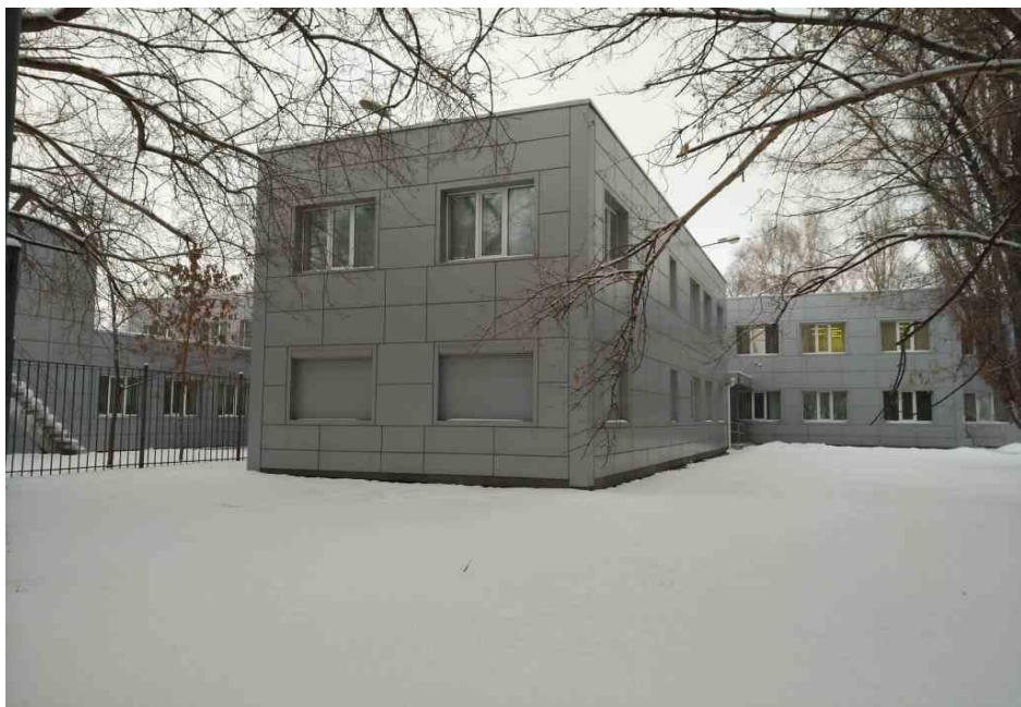
Общий вид административного здания
