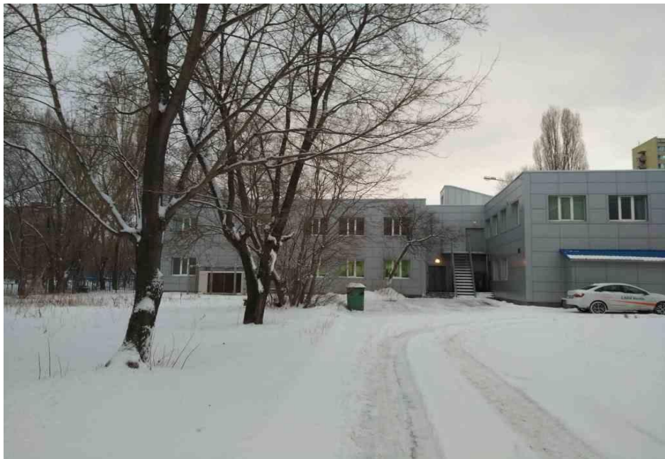
Общий вид административного здания
