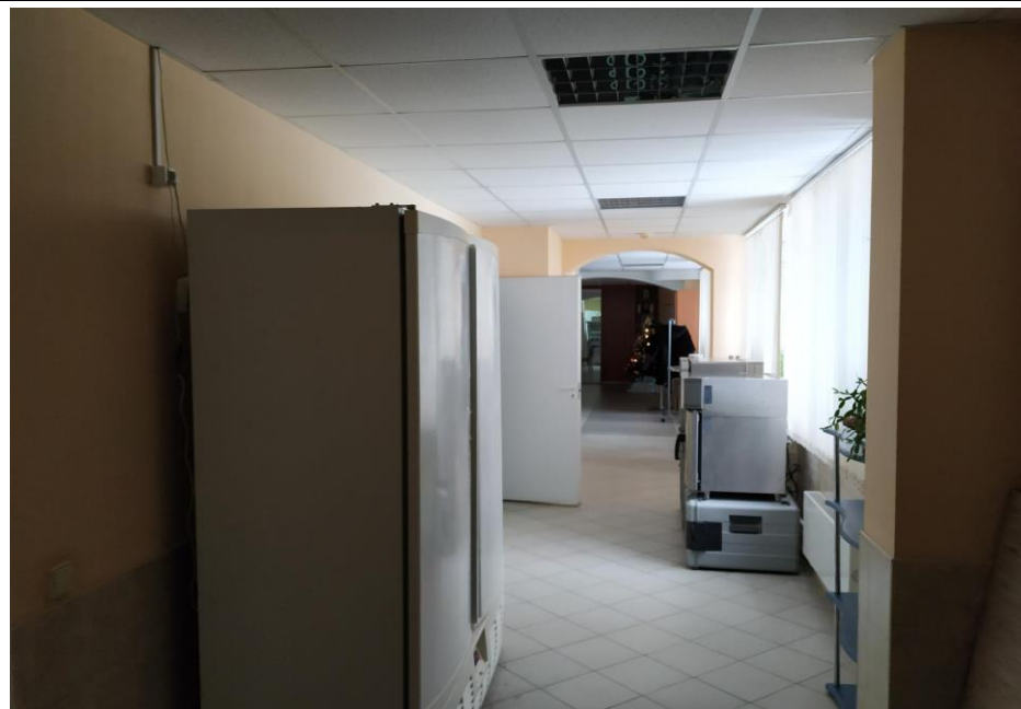
Вид помещений административного здания
