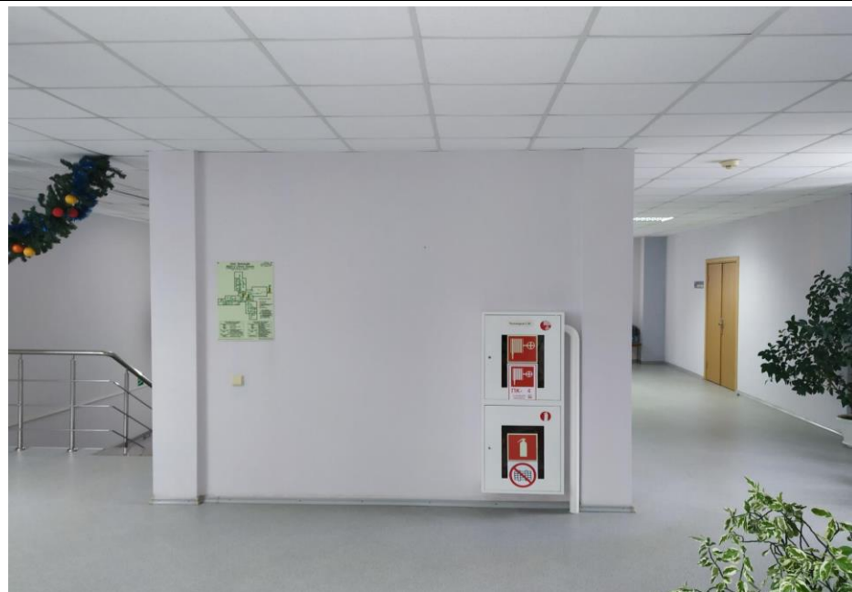
Вид помещений административного здания
